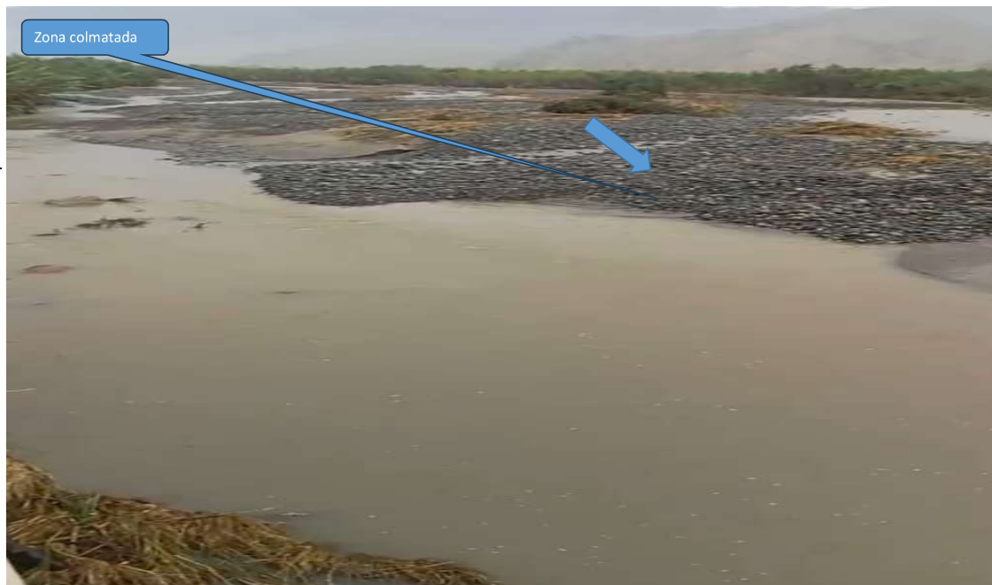
FIGURA N°03: SE MUESTRA LA COLMATACION DEL CAUCE DONDE SE DEBE MANTENER EL CAUCE PARA PROTECCION DE LA BOCATOMA LA PINTA
